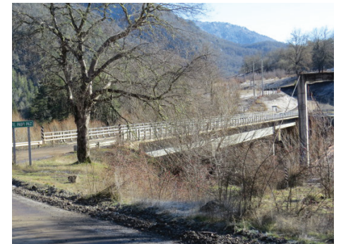
Puente y Pasarela Pazo Paz (Foto Paulo Palma Burgos).
