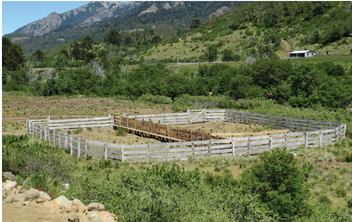
Construcción Manga Comunitaria previa a la veranada. Enero 2013. (Foto: Paulo Palma Burgos).
